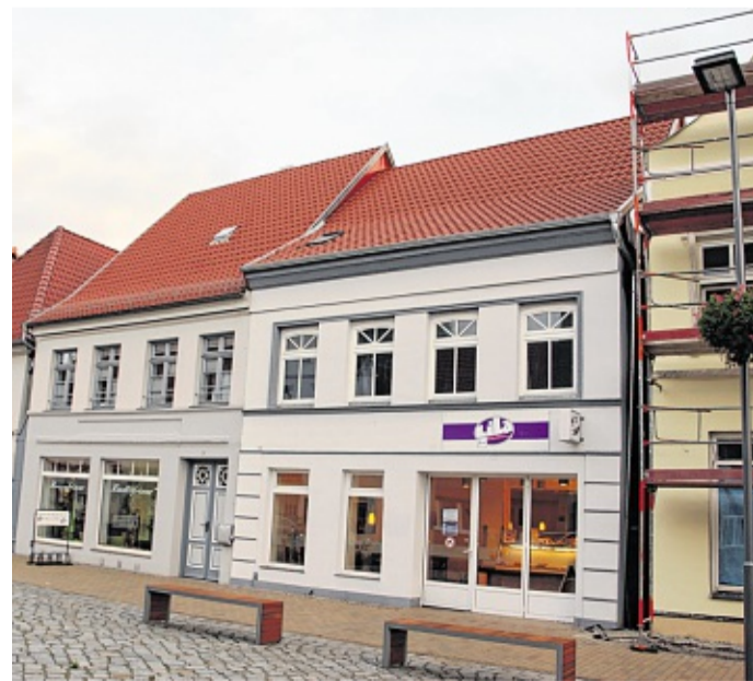
Nachher: Noch wird an einigen Häusern repariert, ein Großteil der Dächer leuchtet aber inzwischen in neuem Rot.
